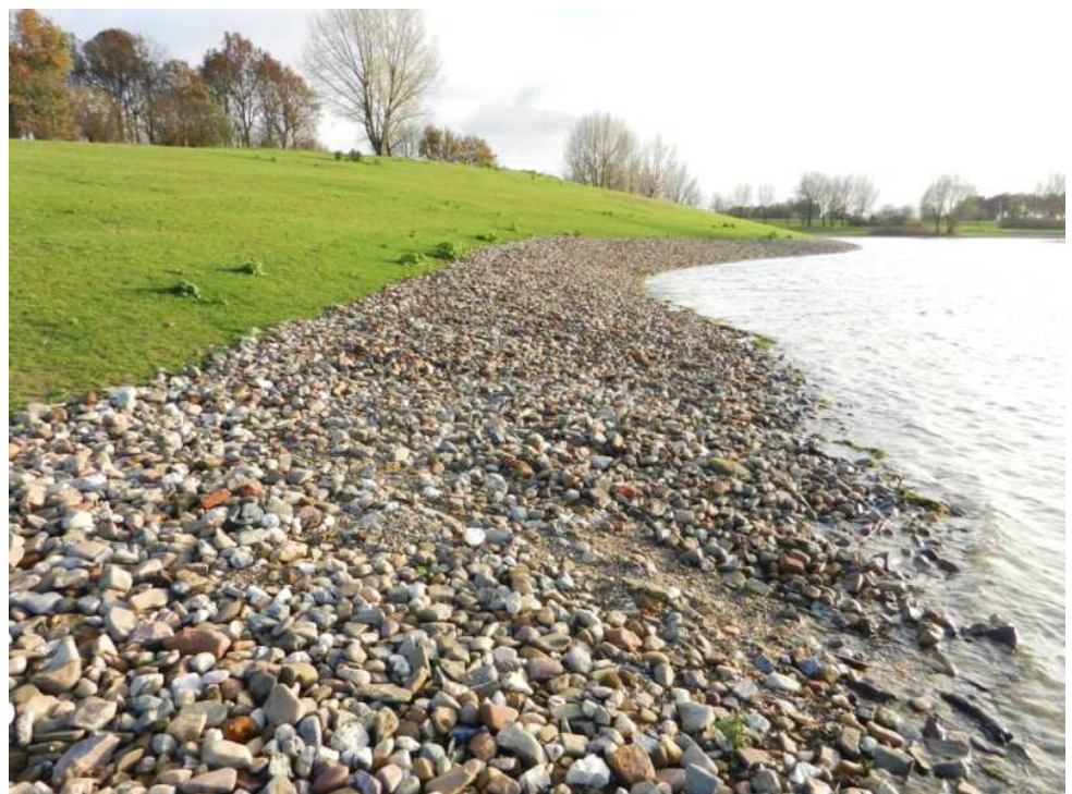
De oever van de Giese Kop bij Giesbeek met het gestorte grind
